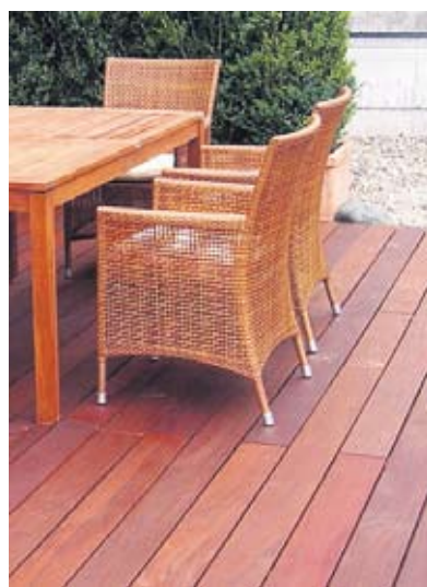
Holzrost aus IPE-Holz, der mit Clips verlegt wurde.
